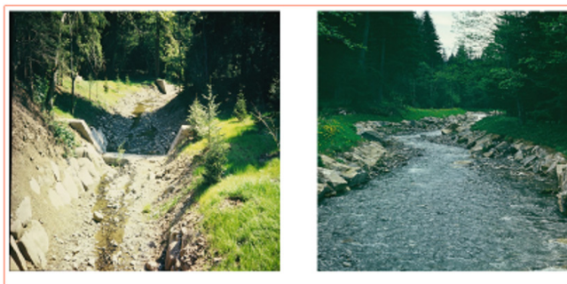
Fig. 8. Înverzirea sectoarelor de albie amenajate – soluție ecologică pentru reconstrucția biodiversității în spațiul albiilor torențiale (Sursa: Fototeca disciplinei de Corectarea Torenților, Universitatea Transilvania din Brașov - foto stânga: Boris Alexa 1977; foto dreapta: Stelian Munteanu 1980)
