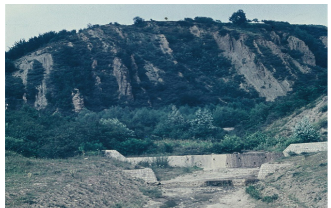
Fig. 6. În condiții extreme sub raportul torențialității, reconstrucția biodiversității (prin reinstalarea vegetației) nu este posibilă decât în prezența unor bariere transversale (Sursa: Fototeca disciplinei de Corectarea Torenților, Universitatea Transilvania din Brașov - foto: Stelian Munteanu 1965)
