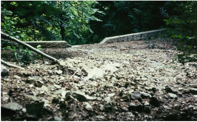
Fig. 4. Bariere depășite dar încă necesare (Sursa: Fototeca disciplinei de Corectarea Torenților, Universitatea Transilvania din Brașov - foto sus: Stelian Munteanu 1960; foto jos: Radu Gaspar 1970)
